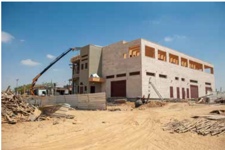
תיכון בבניה | Highschool under construction مدرسة ثانوية قيد الإنشاء
