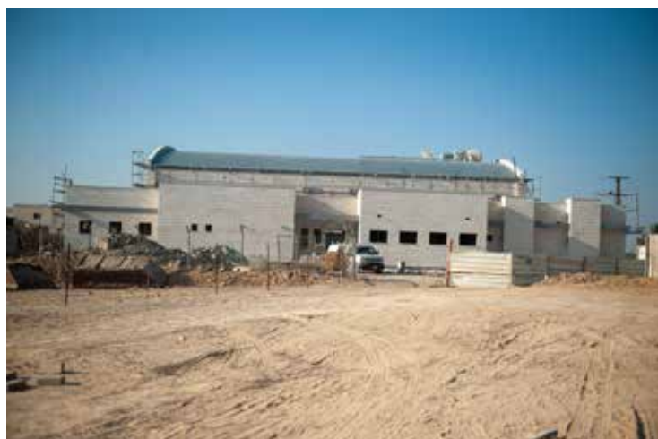
Sports hall under | אולם ספורט בבניה قاعة رياضية قيد الإنشاء constructions
