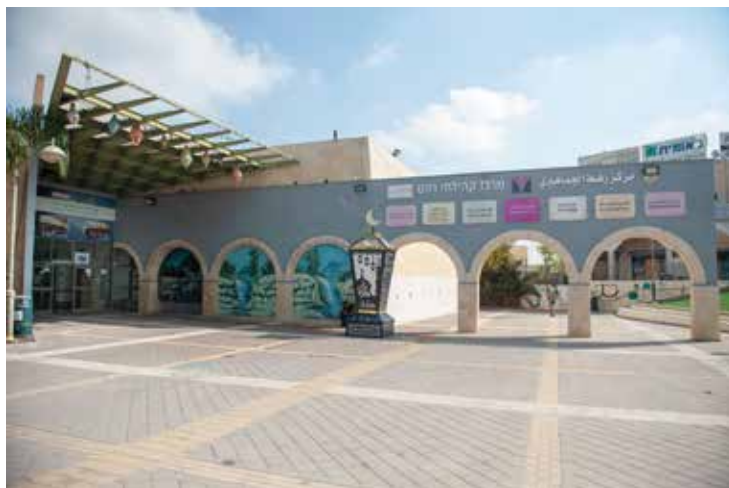
מתנ"ס קהילתי | Community recreation center مركز مجتمعي
