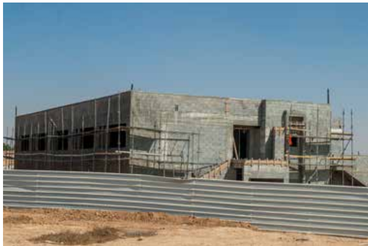
מבנה רב תכליתי בבנייה | Multi-purpose building | under construction מבני متعدد الأغراض قيد الإنشاء
