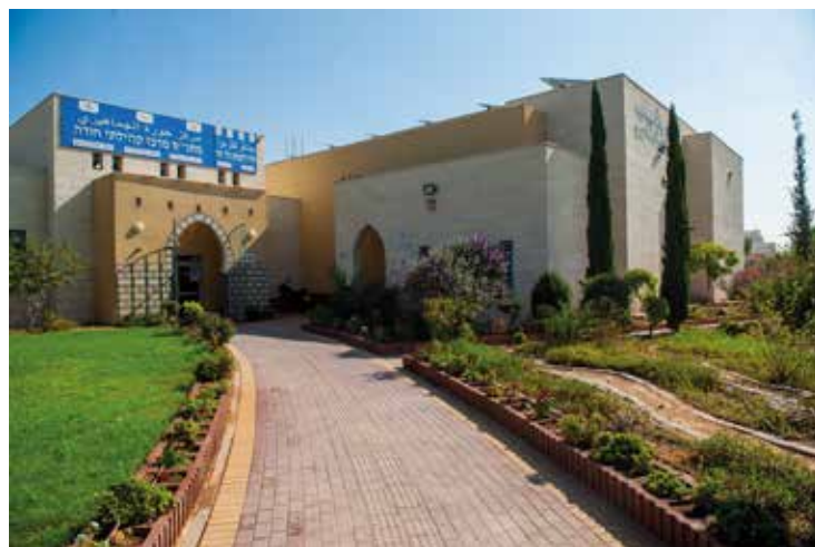
מתנ"ס קהילתי | Community recreation center مركز مجتمعي
