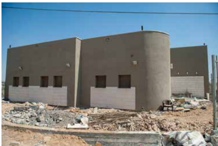
מתנ"ס בבניה | Recreation center under construction | مركز مجتمعي قيد الإنشاء
