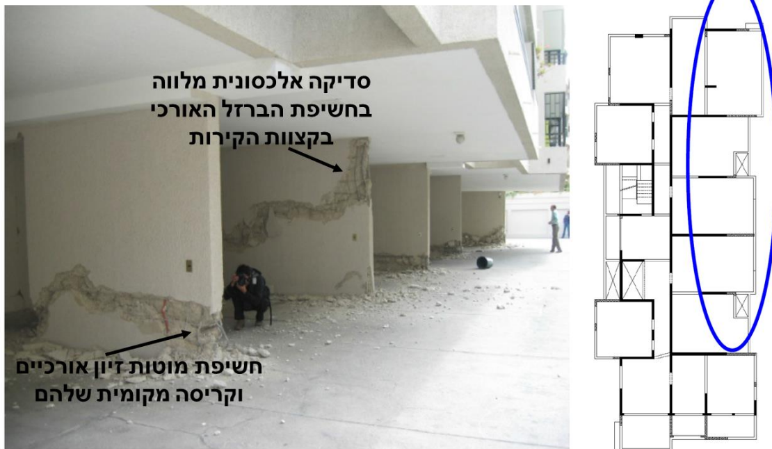
איור מספר 7 - נזק חמור בקירות קומת הקרקע הכולל מערכת הבטון, קריסה וקריעה של מוטות הזיון, וערעור מנגנון הכליאה בקצה הקיר (Bonelli, 2010), (Bonelli, et al., 2011).
