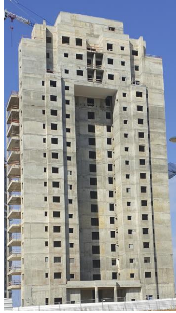
מבט על קיר דגל איור מספר 17 - דוגמאות של מבני מגורים רב קומתיים, בעל מעטפת של קירות עם פתחים ואי רציפות בקומת הקרקע.
