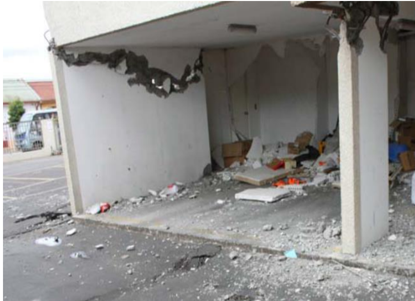
איור מספר 11 - נזק חמור וכשל בקירות מבנה אי סדירות אנכית ואופן העברת כוחות הגזירה והמומנטים בקומת הקרקע (Moehle, 2010), (Bonelli, et al., 2011).
