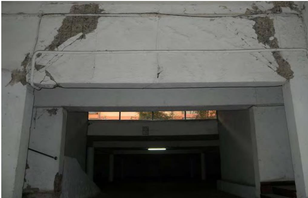
איור מספר 13- נזק חמור של סדיקה אלכסונית וכשל בתחתית קיר עם פתח גדול הנשען על שני נקודות השענה בקומת החניה (Hooper , et al., 2010).
