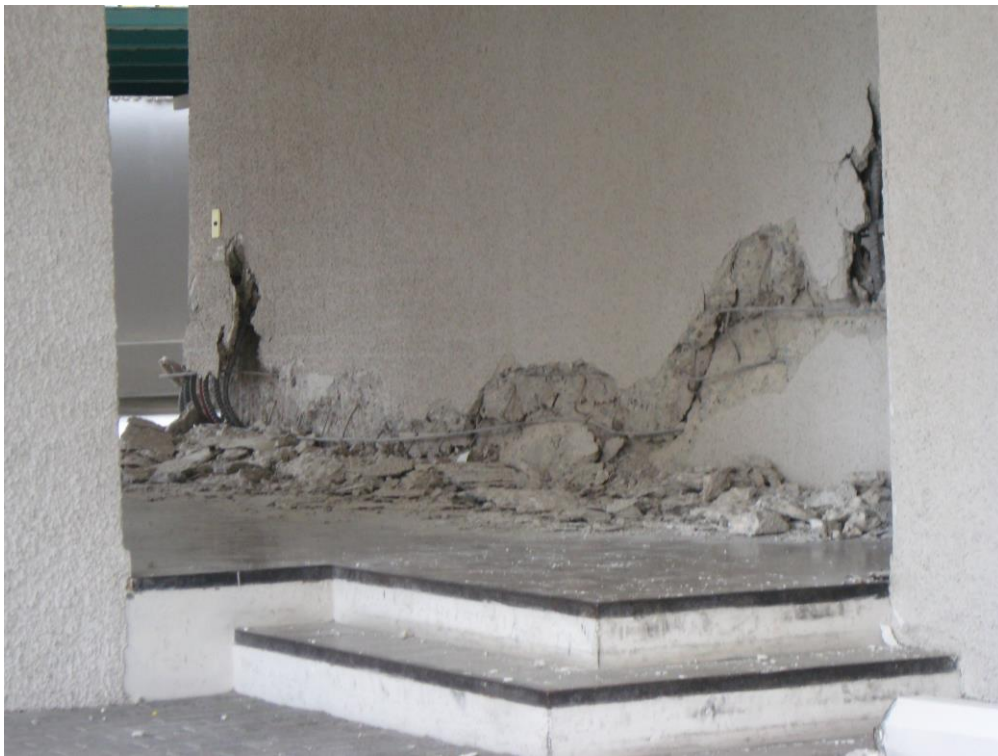
איור מספר 10 - נזק חמור וכשל בקירות מבנה עקב מאמצי לחיצה גדולים (Moehle, 2010), (Bonelli, et al., 2011).
