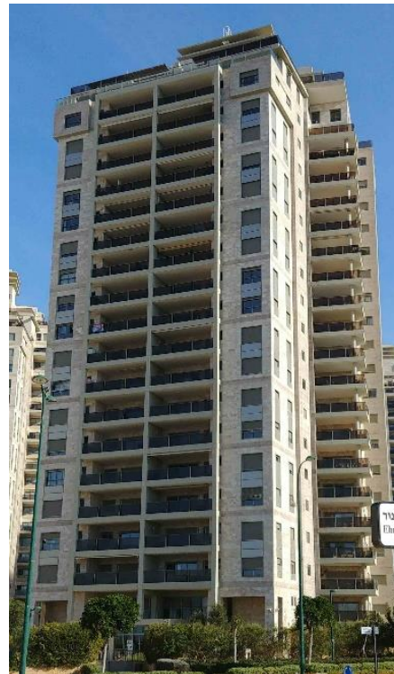
קיר יצוק עם פתחים על עמודי תמך איור מספר 16 - דוגמא של מבנה מגורים רב קומות (מעל 15 קומות) בעל מעטפת של קירות עם פתחים.
