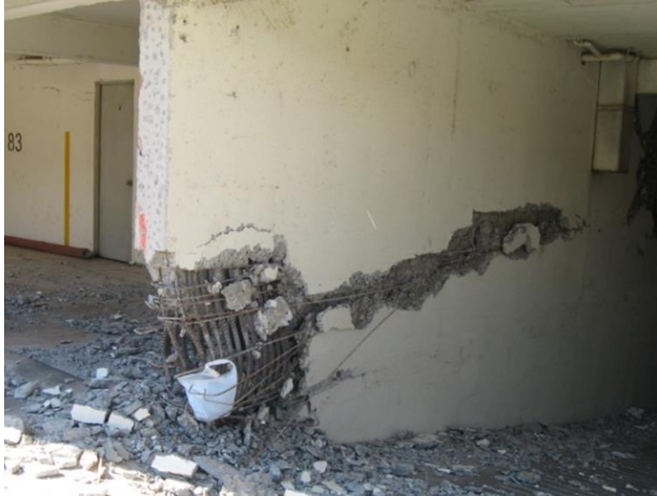
איור מספר 9 - נזק חמור וכשל בקירות מבנה עקב אחוז זיון אנכי ופרטי כליאה לא מספקים (Wallace, et al., 2010), (Bonelli, et al., 2011).
