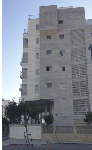
מבט על קיר דגל איור מספר 17 - דוגמאות של מבני מגורים רב קומתיים, בעל מעטפת של קירות עם פתחים ואי רציפות בקומת הקרקע.
