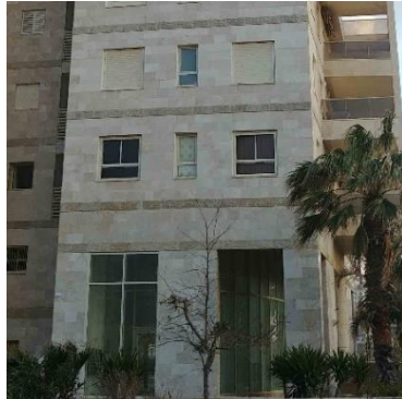
קיר יצוק עם פתחים על עמודי תמך איור מספר 16 - דוגמא של מבנה מגורים רב קומות (מעל 15 קומות) בעל מעטפת של קירות עם פתחים.
