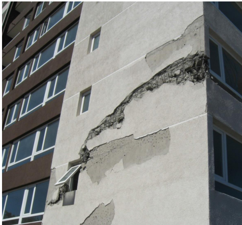
איור מספר 8 - כשל גזירה ונזק חמור בקירות מבנה מגורים חדש בן 25 קומות (Bonelli, et al., 2011).
