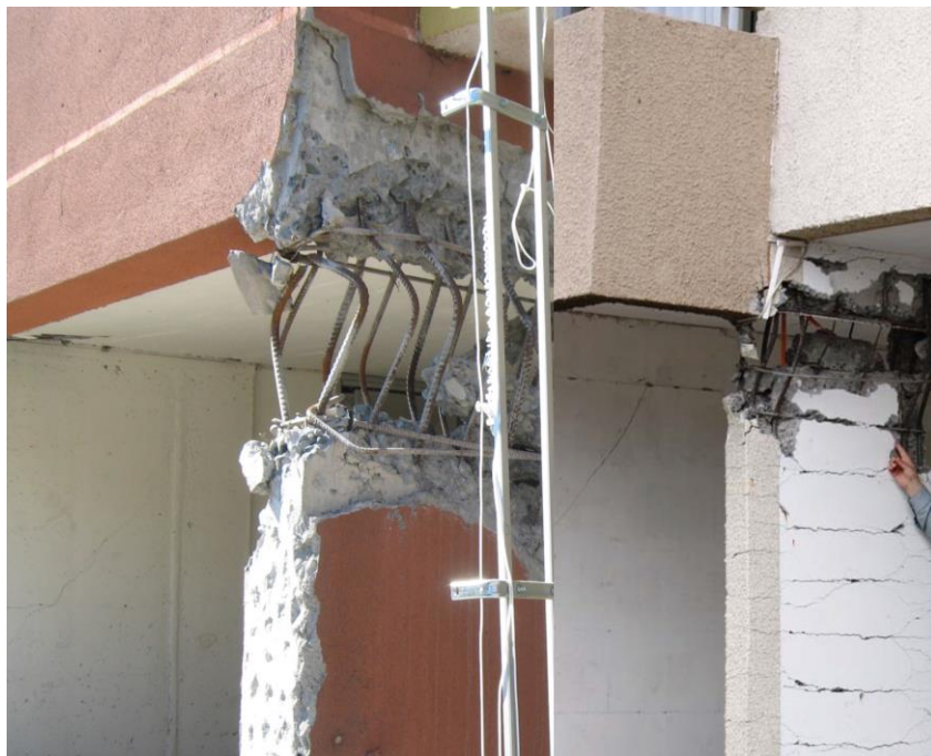
איור מספר 12 - כשל ונזק חמור בקירות ועמודי בטון, חשיפת החישוקים, מעיכה ונפילה של הבטון, חשיפת וקריסה של מוטות הזיון (Bonelli, et al., 2011), (Bonelli, 2010).
