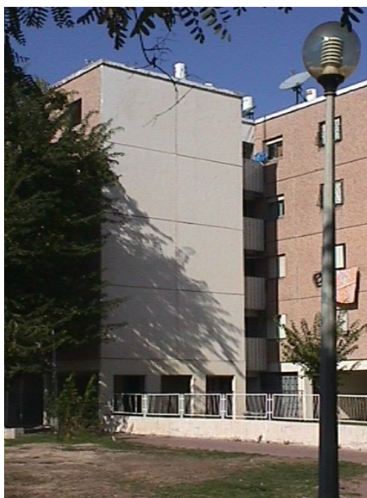
איור 3.5 : מעטפת חיצונית אופיינית מבטון מזויין בבנייני מגורים טרומים קיימים
