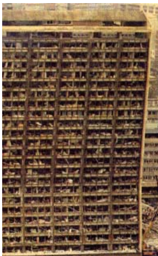
איור 4.31: הרס כללי של רכיבי זיגוג בחזיתות של בניין משרדים רב קומות כתוצאה מפיצוץ מכונית תופת בקרבתו
