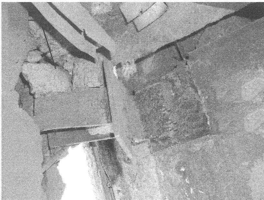
איור 4.7 : הרס מקומי של מחברי פלדה בין ספיני קירות טרומים של בניין המגורים המוצג באיור 4.6, כתוצאה מפיצוץ פנימי של רקטה בקוטר 122 מ"מ
