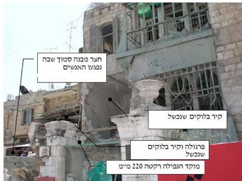
איור 4.19: הרס מקומי של קירות נושאים מלבנים מחופים באבן והינזקות רכיבי שלד בטון מזויין של בניין מגורים כתוצאה מפגיעה קרובה של רקטת 220 מ"מ
