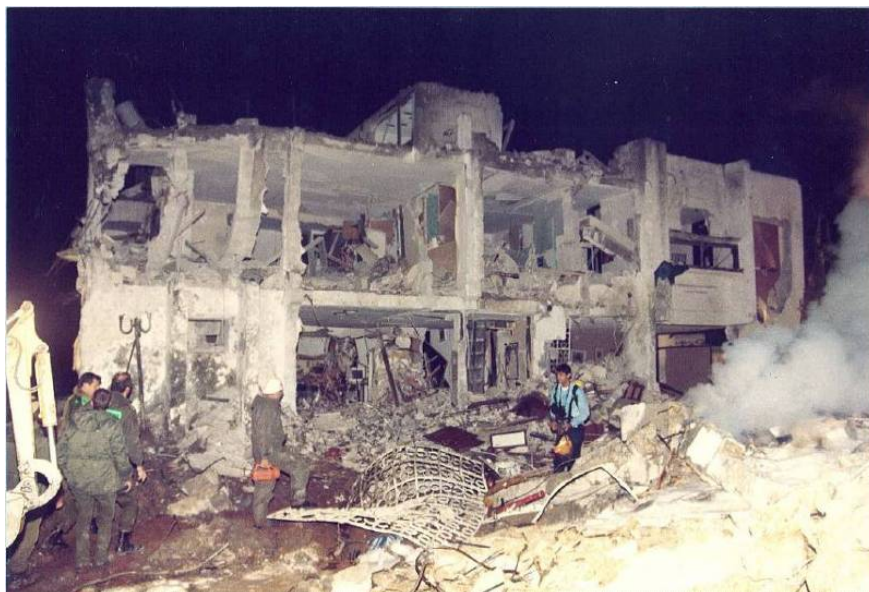
איור 4.23: הינזקות קשה של בניין מגורים קונוונציונלי שלוד מבטון מזויין כתוצאה מפגיעה קרובה של טיל "סקאד"
