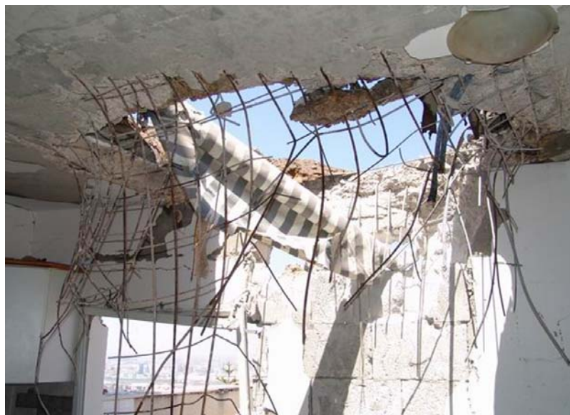
איור 4.11: פריצה והרס מקומי של רצפת מקשית מבטון מזוין של מרפסת גג בבניין מגורים מדורג כתוצאה מפגיעה ישירה של רקטת 220 מ"מ
