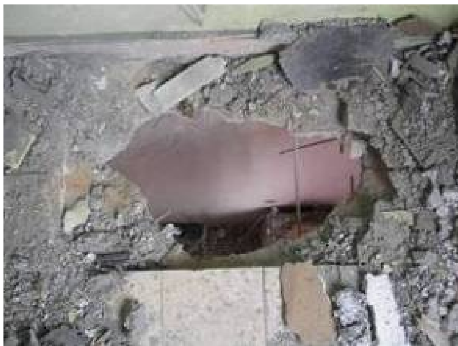
איור 4.2: פריצה והרס מקומי של רצפת ביניים בבניין מגורים טרום כתוצאה מפגיעה ישירה של רקטת 122 מ"מ במעטפת חיצונית של הבניין אשר נחדרה על ידי הרש"ק בטרם התפוצצותו
