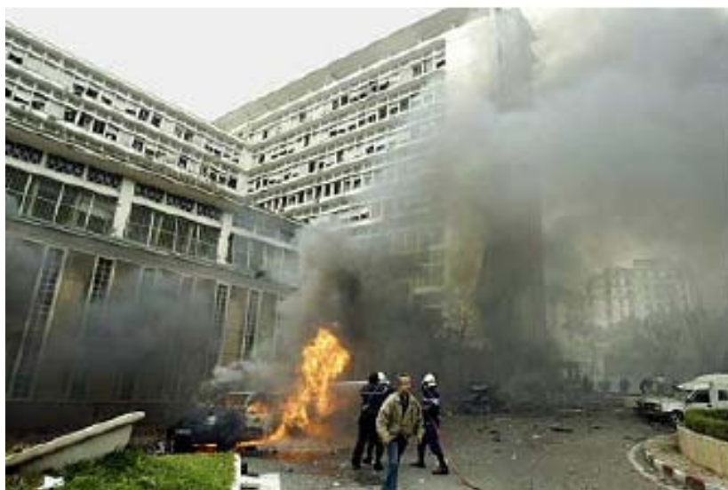
איור 4.30: היפגעות חלונות בחזיתות של בניין כתוצאה מפיצוץ מכונית תופת בקרבתו
