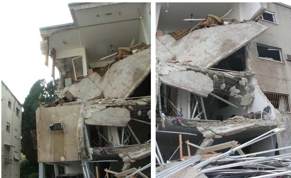
איור 4.13: התמוטטות חלקית של בבניין מגורים בן 4 קומות הבנוי בשיטת בנייה קונוונציונלית כתוצאה מפגיעה ישירה של רקטת 220 מ"מ
