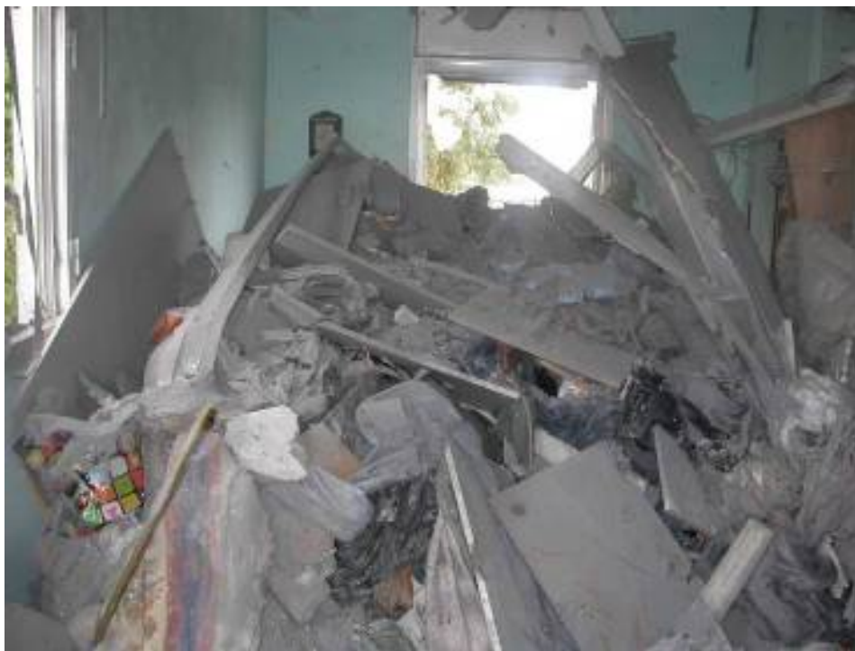
איור 4.5: נזק נרחב לרכיבי בניין ולתכולתו. בחלל פנימי של בניין מגורים, כתוצאה מפיצוץ פנימי של רקטת 122 מ"מ לאחר שחדר דרך גג הבניין
