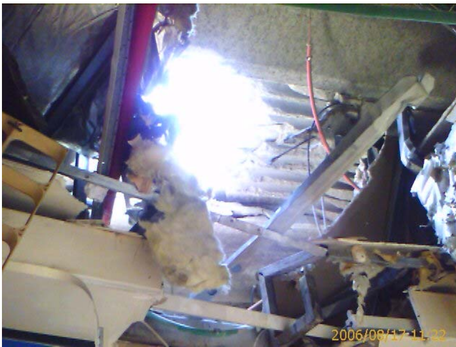
איור 4.4: פריצה והרס מקומי נרחב של גג בניין מלוחות בטון חלולים טרומים דרוכים כתוצאה מפגיעה ישירה של רקטת "קטיושה"
