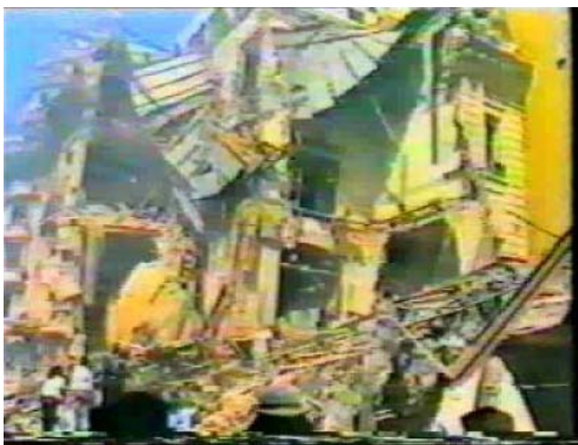
4.27 : התמוטטות כללית של חלק נרחב של בניין בלתי שלוד עם קירות בני נושאים כתוצאה מפיצוץ מכונית תופת בקרבתו(בואנוס איירס – ארגנטינה)
