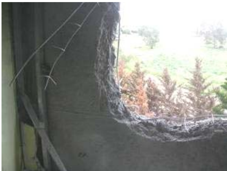
איור 4.1: פריצה והרס מקומי של קיר מעטפת בבניין מגורים טרום כתוצאה מפגיעה ישירה של רקטת 122 מ"מ מזויין טרומים, כתוצאה של פגיעה ישירה של רקטת 122 מ"מ
