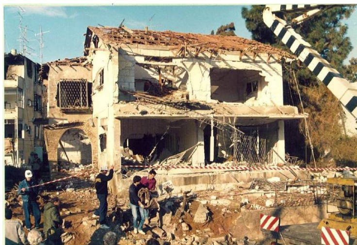
איור 4.22: הינזקות קשה של בניין מגורים קונוונציונלי שלוד עם גג מקונסטרוקציית עץ וקירוי רעפים כתוצאה מפגיעה קרובה של טיל "סקאד"
