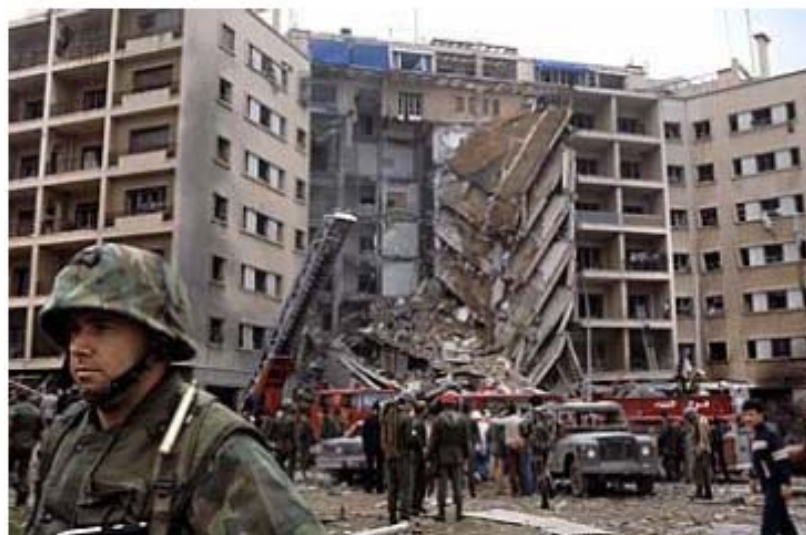
4.26 : התמוטטות חלקית בשרשרת של בניין קונונציונאלי שלוד מבטון מזויין כתוצאה מפיצוץ מכונית תופת בקרבתו (בירות – לבנון)
