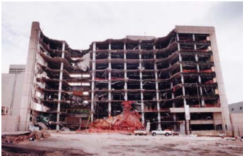
איור 4.25: התמוטטות בשרשרת של חלקים נרחבים של בניין פדראלי Murrah באוקלהומה סיטי, כתוצאה מפיצוץ מכונית תופת בקרבת הבניין
