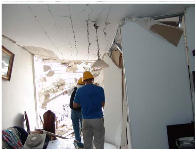
איור 4.14: נזק/הרס בכפיפה אם כי ללא התמוטטות של תקרת ביניים בבניין מגורים המוצג באיור 4.13, אשר נפגע בפגיעה ישירה של רקטת 220 מ"מ
