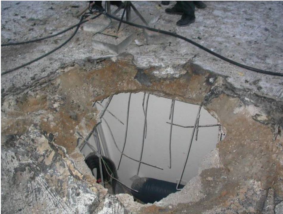
איור 4.3: פריצה והרס מקומי של גג מבטון מזויין של בניין מגורים כתוצאה מפגיעה ישירה של רקטת 122 מ"מ
