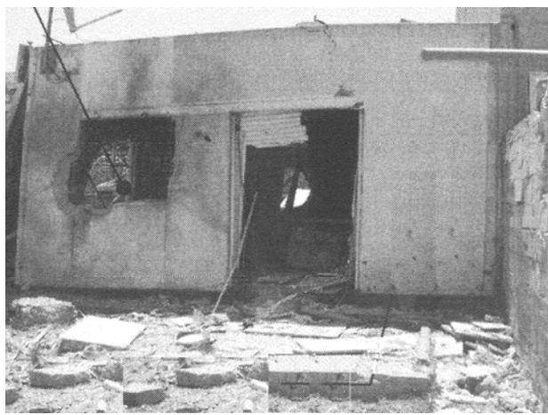
איור 4.6: נזק כבד/הרס של קטע בניין מגורים חד קומתי טרום כתוצאה מפיצוץ פנימי של רקטה בקוטר 122 מ"מ לאחר פגיעה ישירה וחדירתו לבניין
