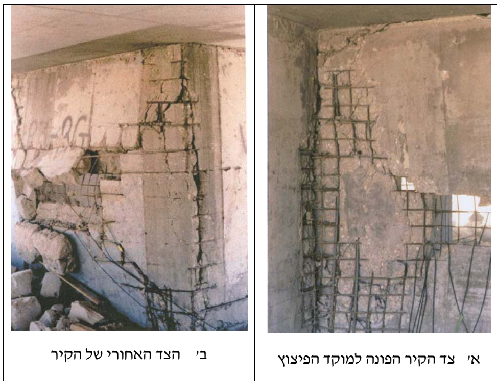
איור 2.12: פריצת קיר בטון מזוין בעל עובי מוגבל כתוצאה של פיצוץ מטען חומר נפץ גדול בקרבתו – מרחק מקונום של מוקד הפיצוץ – z \approx 1.00 \text{ m/kg}^{1/3}
