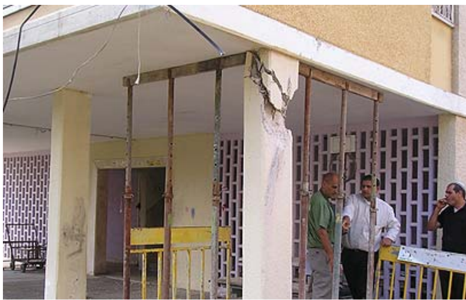
איור 4.8 : הרס מקומי של עמוד בקומת קרקע פתוחה של בניין מגורים קונוונציונלי מבטון מזויין כתוצאה של פגיעה ישירה של רקטת "קסאם"
