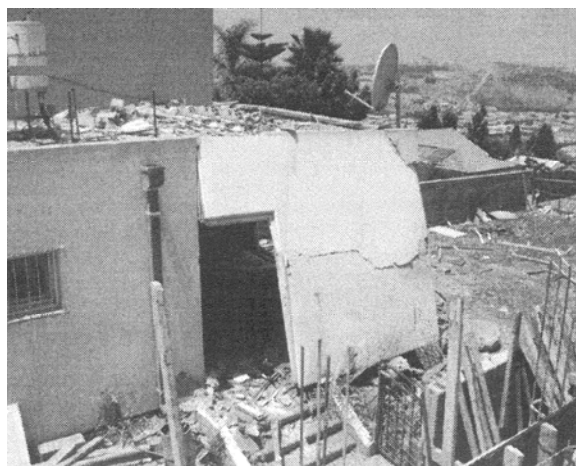
איור 4.6: נזק כבד/הרס של קטע בניין מגורים חד קומתי טרום כתוצאה מפיצוץ פנימי של רקטה בקוטר 122 מ"מ לאחר פגיעה ישירה וחדירתו לבניין
