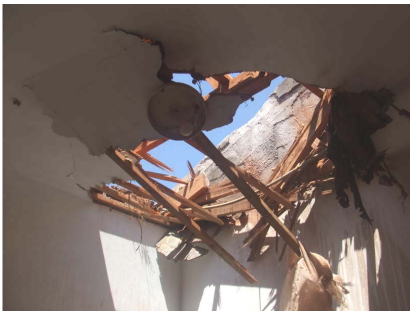
איור 4.9: פריצה והרס נרחב של גג רעפים בבניין מגורים הכולל קונסטרוקציית עץ ותקרה תותבת תחתונה (תקרת "רביץ") כתוצאה מפגיעה ישירה של רקטת "קסאם"
