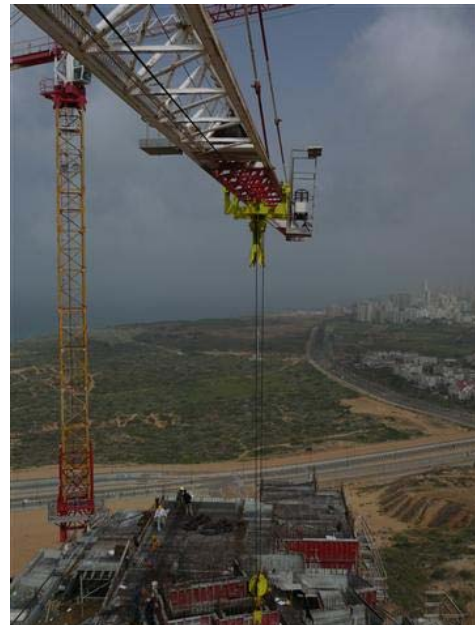
איור 4-8 אתר הניסוי: מצלמה כעזר ראייה (מימין: המצלמה על הזרוע הקדמית של העגורן; משמאל: תקריב של מתקן המצלמה)
