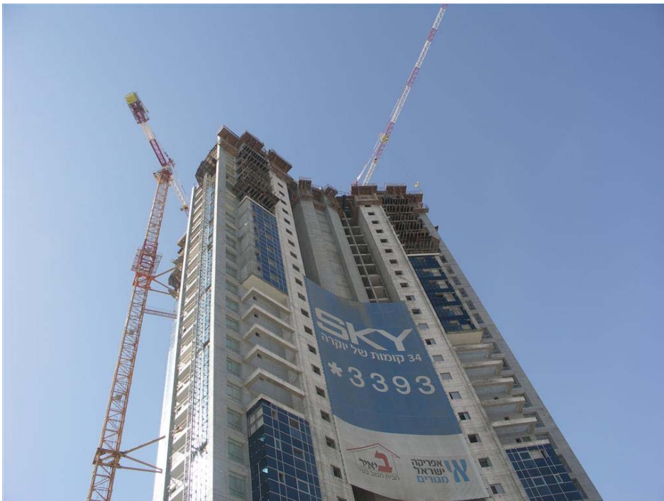
איור 4-4 אתר הניסוי: שני עגורנים חופפים (בשני שלבים שונים של התקדמות הביצוע)
