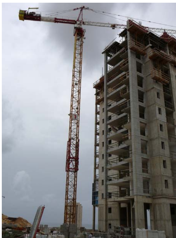
איור 4-3 אתר הניסוי: הבניין ועגורן הניסוי
