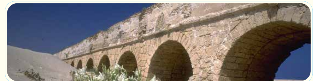
El acueducto en la antigua Cesarea | Yael Ilan, GPO
