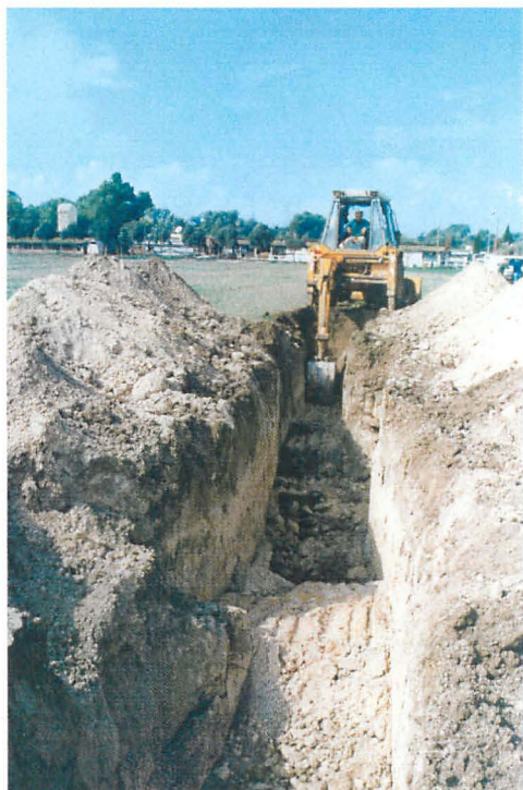
Figure 6.18. Ein HaMifratz Southern trench.
