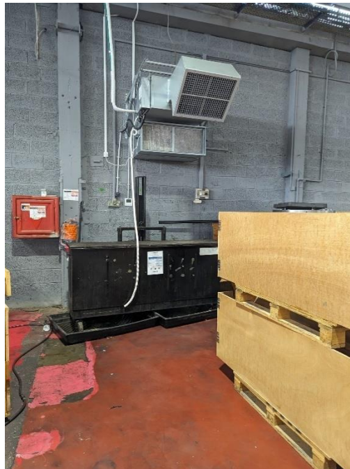
איור 5. עמדת מיזוג אישית לעובד בתעשייה הבטחונית. עמדת מיזוג ייעודית לעמדת עבודה הינה חסכונית באנרגיה משום שאינה כרוכה במיזוג כלל ההאנגר התעשייתי בעל התקרה הגבוהה, אלא היא מיועדת למזג רק את סביבת העובד.
