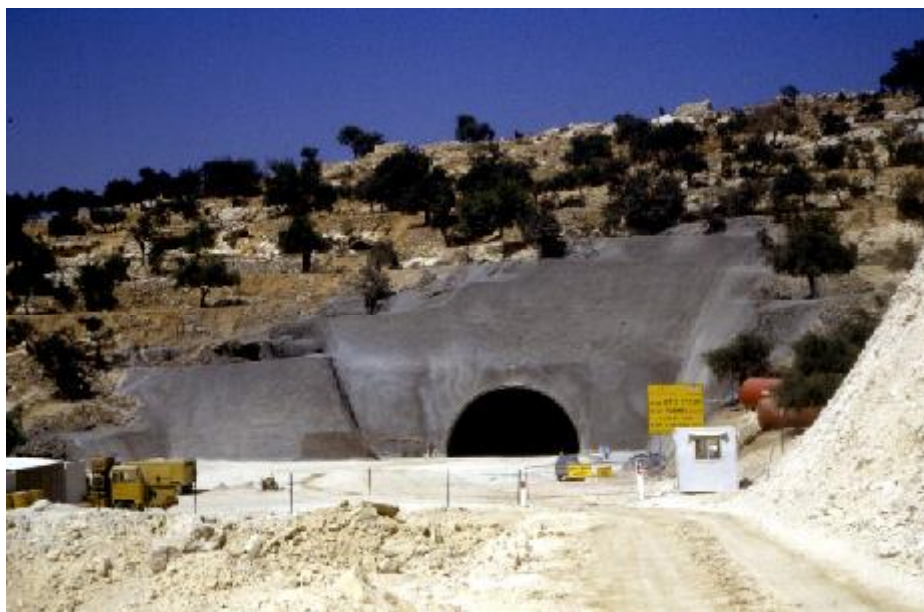
איור מס' 12. מראה של הכניסה הצפונית של מנהרת גילה הקצרה בתצורת כפר שאול בזמן הבניה.
