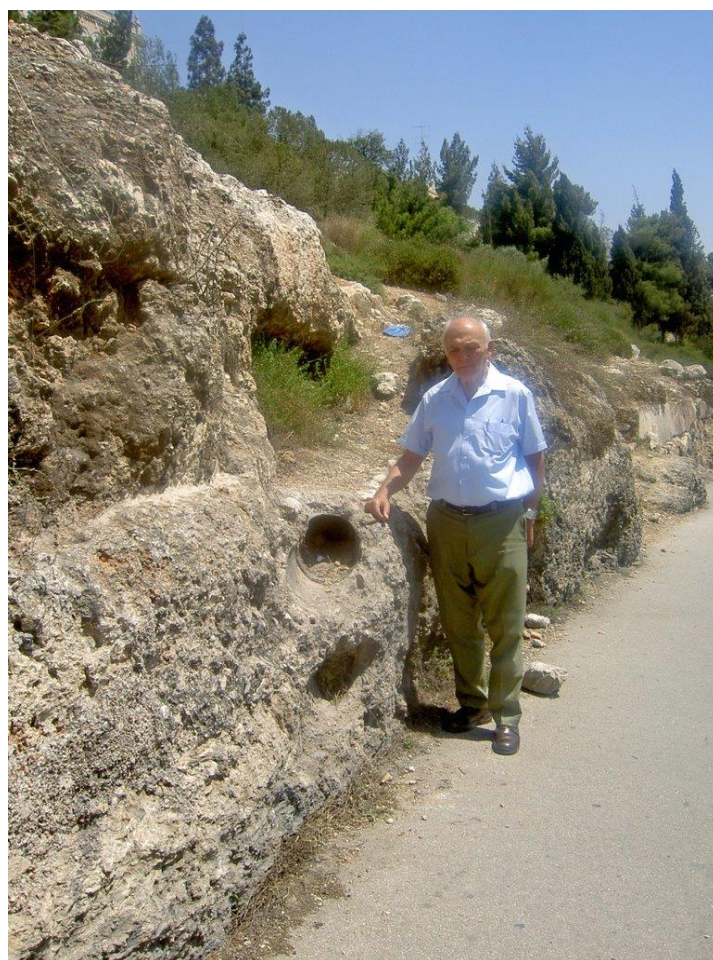
איור מס' 41. אמת המים התחתונה בצדו המערבי של הר ציון ליד ברכת הסולטאן. צינור חרס עותמני מותקן בתוך האמה.
