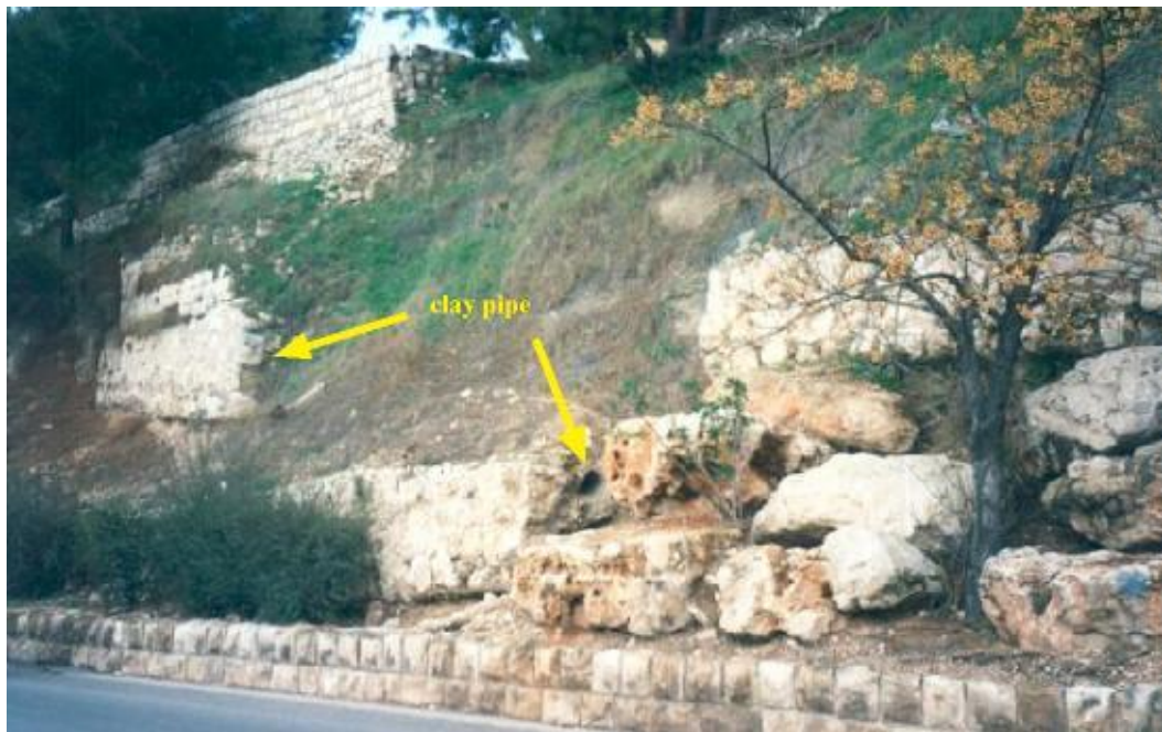
איור מס' 40. אמת המים התחתונה בצדו הדרומי של הר ציון, שבורה בחלקה ובתוכה צינור החרס שהונח על ידי העותמנים.
