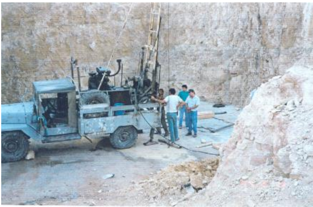
איור מס' 24. קדיחת קידוחי תצפית והזרקת מלט, (Grouting) בבור הבסיס של העמוד Do.
