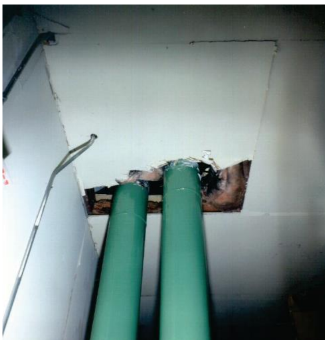
איור 6.4.3.4-1 – תזוזה בצינורות אנכיים ברעידת אדמה – פגיעה בגמר התקרה ובחומרי הבידוד.
