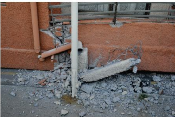
איור 3-6.4.5.2 – מערכת צינורות במבנה שהתמוטט באחד מצדדיו. הצינור השבור היחיד (מוצג מימין למטה) ממוקם בצד שהתמוטט. שאר הצינורות גרמו לשבר בחלק מהתמיכות, אך המחברים נשארו שלמות למרות ההזזות הגדולות.
