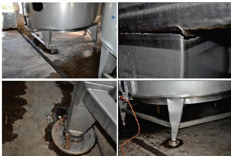
איור 4-6.4.2.1 – מיכלים ביקב שנפגעו ברעידת אדמה. ניתן לראות כשלים שונים: כשל בעיגון ברגים, כשל בקריסה של רגלי התמיכה, כשל בריתוכים. שימוש בברגים לפילוס גובה המיכלים גרם ליצירת אזור חלש בין תחתית הרגלים לרצפת חלל האחסון.
