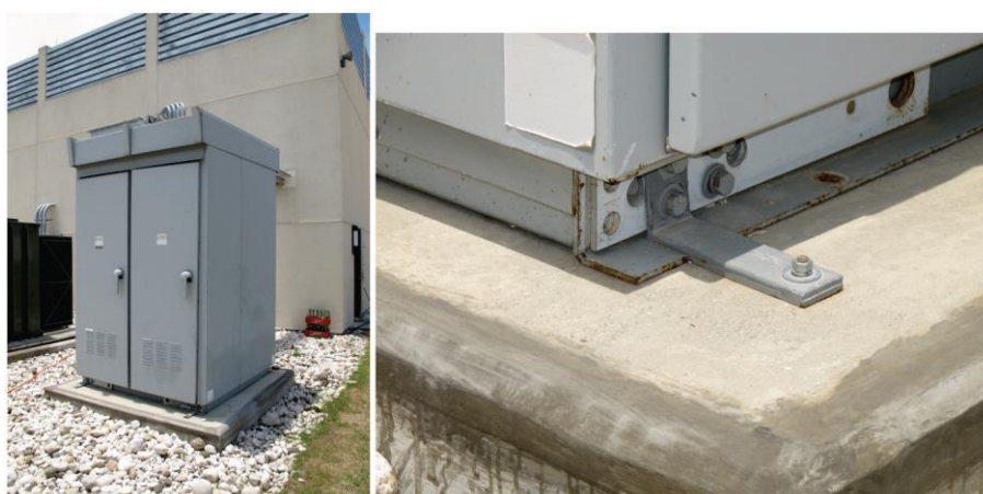
איור 6.4.7.3-4 – ארון חשמל חיצוני למתח נמוך המספק כוח חיוני למתקן חשוב. שימו לב כי הצידוד מעוגן סיסמית באמצעות חיבורים קשיחים ארוכים המוברגים למסגרת הצידוד ולפלטת הבסיס. התמונה צולמה לאחר רעידת אדמה.
