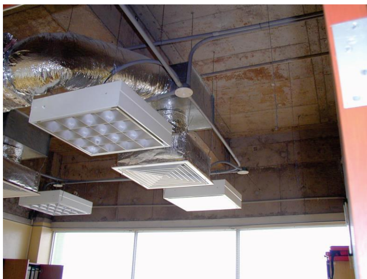
איור 6.4.6.2-2 – מפזרי אוויר שמחוברים לתקרה באמצעות ארבעה מתלים אנכיים. מערכות התקרה נפגמו ברעידה, אך מפזרי האוויר והמנורות לא נפלו. התקרה נהרסה טרם צילום התמונה.
