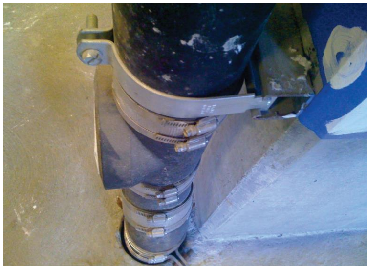
איור 6.4.5.2-5 – דוגמה להתקנה לקויה של תמיכה בצנרת סניטרית. המרחק של החבק מקצה הקורה התומכת איננו תקין והוא עלול להחליק החוצה.
