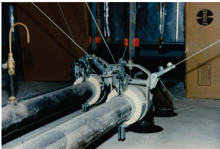
איור 5-6.4.3.8 – צנרת חוזרת רצפה עם פתח מורחב ועיגונים צדדיים ואנכיים מעל ובסמוך לפני הרצפה.
