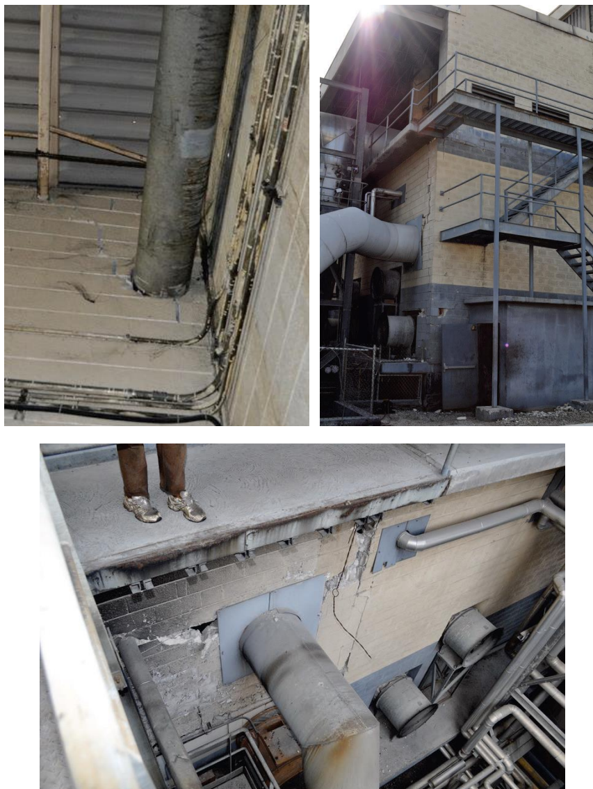
איור 6.4.3.8-3 – צנרת ותעלות חודרות קיר גרמו לפגיעה בקירות בלוקים לא מזויינים במפעל תעשייתי. הצנרת והתעלות לא נפגעו, אך הקיר ניזוק ונדרש לעבור תיקון.
