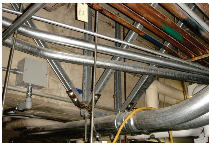
איור 3-6.4.8.1 – תמיכה אלכסונית קשיחה המחברת למסגרת התומכת צנרת חשמל. הצנרת מחוברת למסגרת באמצעות חבקים המספקים עיגון בכיוון האורכי והניצב.
