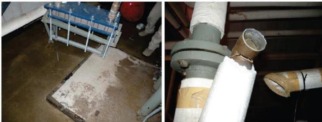
איור 6.4.5.2-1 – שבר בצנרת נחושת להעברת מים חמים. הכשל נגרם עקב תזוזת דוד החימום המוצג מצד שמאל.
