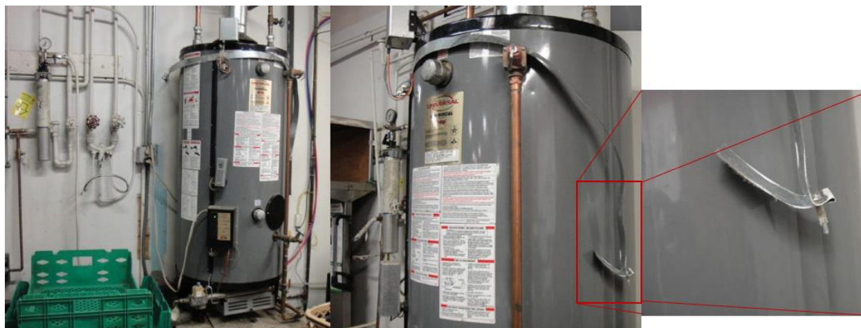
איור 6.4.2.4-3 – עיגון דוד לא-ראוי שנתלש, בעקבות השחרור הדוד פגע בקווי הצנרת המחוברים אליו.
