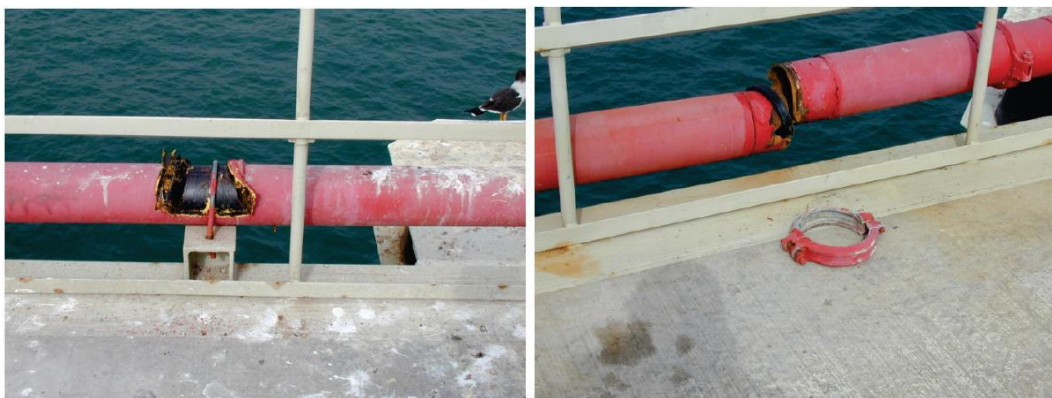
איור 6-6.4.4.1 – נזק לצנרת כיבוי אש תעשייתית. מצד ימין – כשל במחבר להצמדת צינורות ומעיכת הצנרת; מצד שמאל – החלקה בכיוון האורכי במחבר U הנותר שלם, אך המחברים האחרים נשברו ונפלו.
