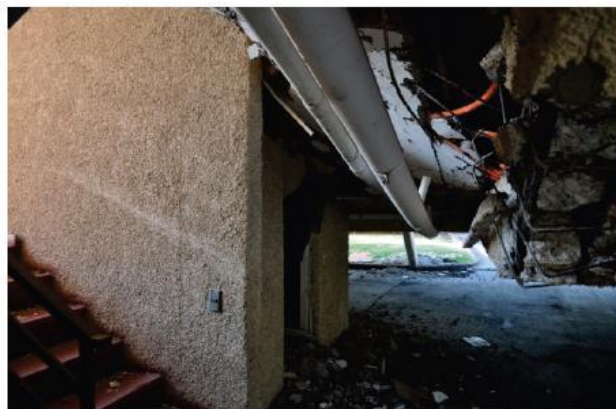
איור 3-6.4.5.2 – מערכת צינורות במבנה שהתמוטט באחד מצדדיו. הצינור השבור היחיד (מוצג מימין למטה) ממוקם בצד שהתמוטט. שאר הצינורות גרמו לשבר בחלק מהתמיכות, אך המחברים נשארו שלמות למרות ההזזות הגדולות.
