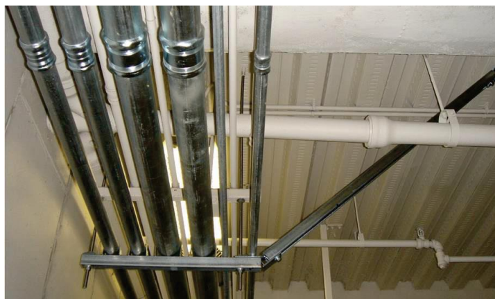
איור 2-6.4.8.1 – תמיכה אלכסונית קשיחה המהווה עיגון נגד כוחות רעידת אדמה בכיוון הניצב. תמיכה דומה נדרשת בכיוון האורכי של התעלה.
