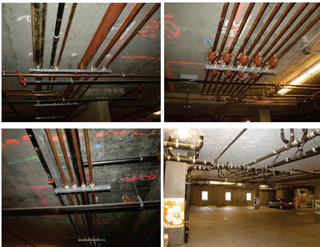
איור 6.4.5.2-6 – צנרת המותקנת בחניון מסחרי. יודגש כי לצינורות ולמתלי אגס אין עיגון בכיוון הניצב, מכיוון שכל המתלים שמרו על אורך הקצר מ- 30 ס"מ. במקרה זה קווי המתלים בלבד עוגנו בכיוון הניצב.
