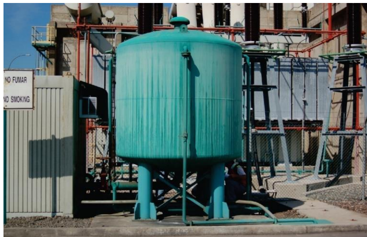
איור 6.4.2.1-7 – תוספת מחברי ואלכסוני פלדה בארבעת הרגלים התומכות מיכל אנכי.
