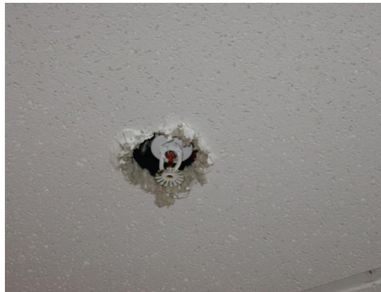
איור 7-6.4.4.1 – דוגמה להתנגשות בין יחידות מתזי המים לסוגים שונים של גימורי תקרה אשר הובילו לנזק בתקרה ובמתלים ולנזקי רטיבות בשדה תעופה.
