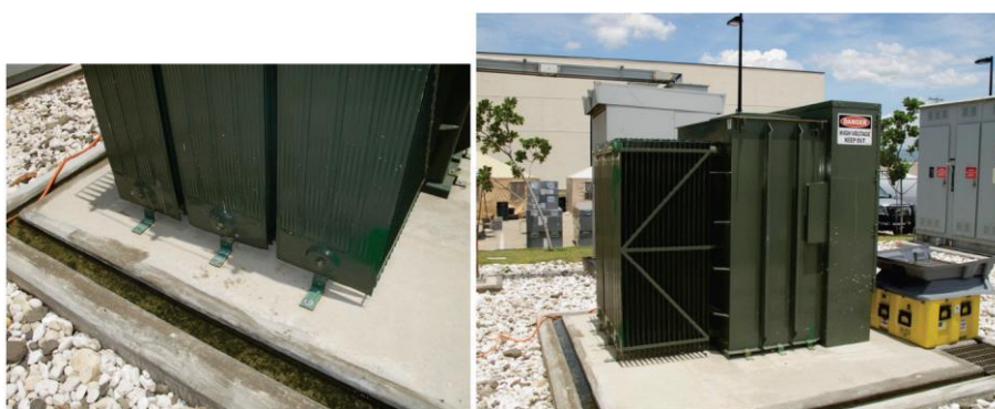
איור 6.4.7.3-5 – שניי שמן חיצוני הממיר מתח עבור מתקן חשוב. שימו לב לרכיבים האלכסוניים על המצנן במטרה למזער את ההעמסה הדינאמית על מיכל הנזולים המכיל מספר חיבורים מרותכים.
