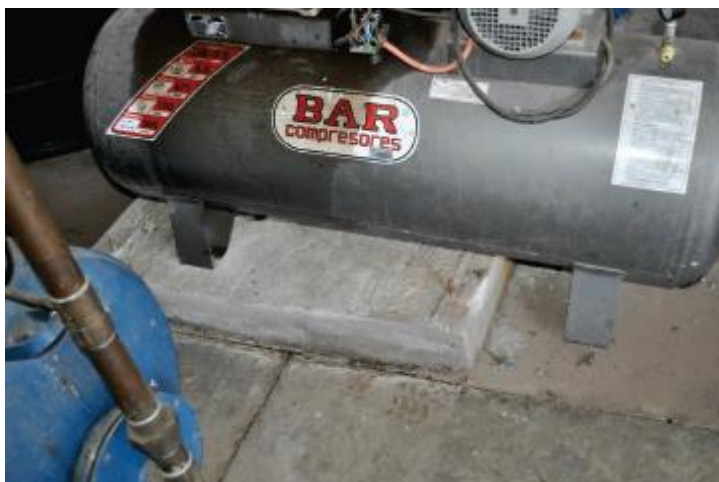
איור 6.4.1.4-1 – החלקה של הקומפרסור ונפילה מבסיסו עקב עיגון לא תקני.
