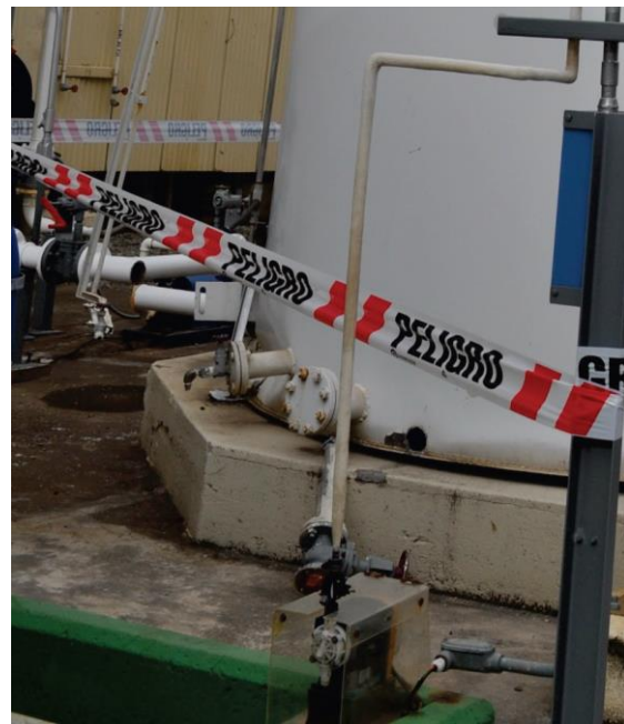
איור 3-6.4.5.1 – נזק למיכלי דלק שעוגנו באופן לקוי שגרם לפגיעה בקווי אספקת הדלק. תמונת התקריב מציגה כשל בצינור באזור מחבר מרותך (משמאל) ומקטע צינור עם שסתום מחובר (בחזית) שנתלש מתוך המיכל.
