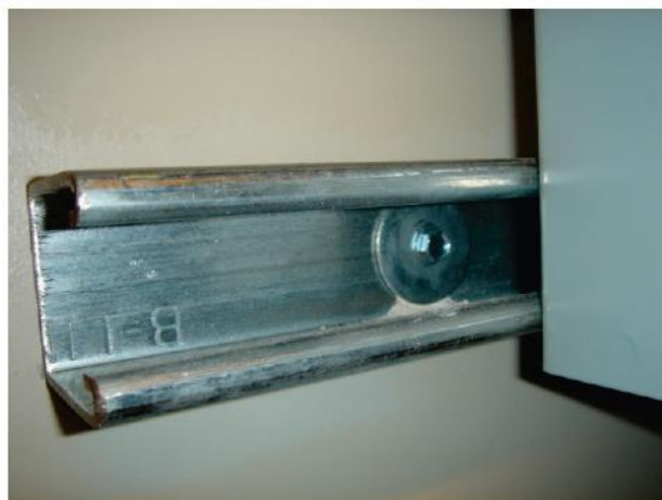
איור 6.4.8.2-2 – לוח חשמל המעוגן לקיר. הלוח מחובר לאלמנט פלדה תומך אשר מחובר לקיר.
