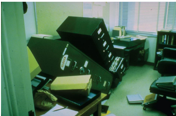
איור 2-6.5.5.1 – נזק לציוד משרדי עקב רעידת אדמה.
