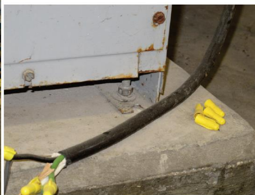
איור 2-6.4.7.3 – שנאי מפצל יבש טיפוס. שימו לב לעיגוני הבסיס שיוצרו כחלק מהמתקן. התמונה צולמה לאחר רעידת אדמה.
