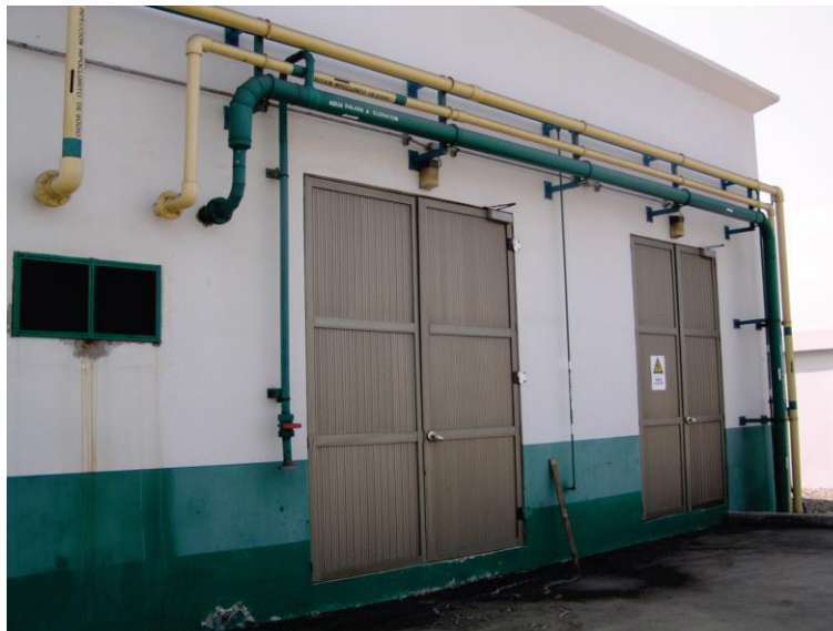
איור 6.4.3.7-1 – עיגון צנרת אופקית ואנכית לקיר חיצוני. ניתן לראות כי נוצר נזק קל לצנרת היורקה החודרת לקיר וכי המחברים הוסטו קלות, אך העיגון תפקד טוב באופן כללי.
