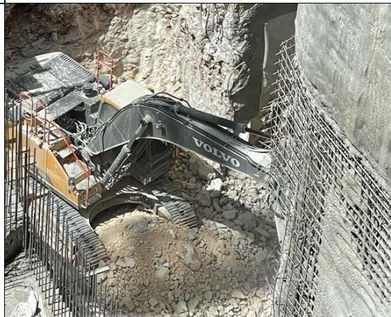
ירושלים, חפירת פירים שמתחברים למנהרת חניון הרכבת. העובד מבצע עבודות ניקיון בסמוך לאזור החפירה
