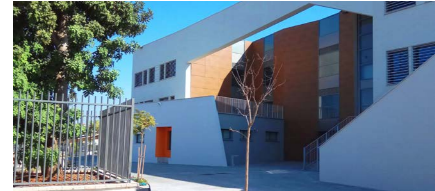
בית ספר לובה אליאב בראשון לציון, אשר נבנה בבנייה ירוקה בדרגת 3 כוכבים, הראשון בישראל | צילום: יקיר למדן
