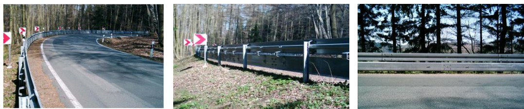
איור 6: דוגמא למערכת מעקה פלדה בתוספת ממ"א המאושרת בגרמניה: ESP 4.0 UFS (גם מוכרת בשם Euskirchen)
