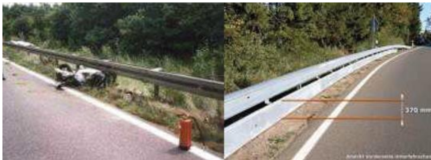
איור 3. א.: מעקה בטיחות מפלדה עם וללא פס מגן לרוכבי אופנוע, מקור: 2-Be-Safe (2012)
