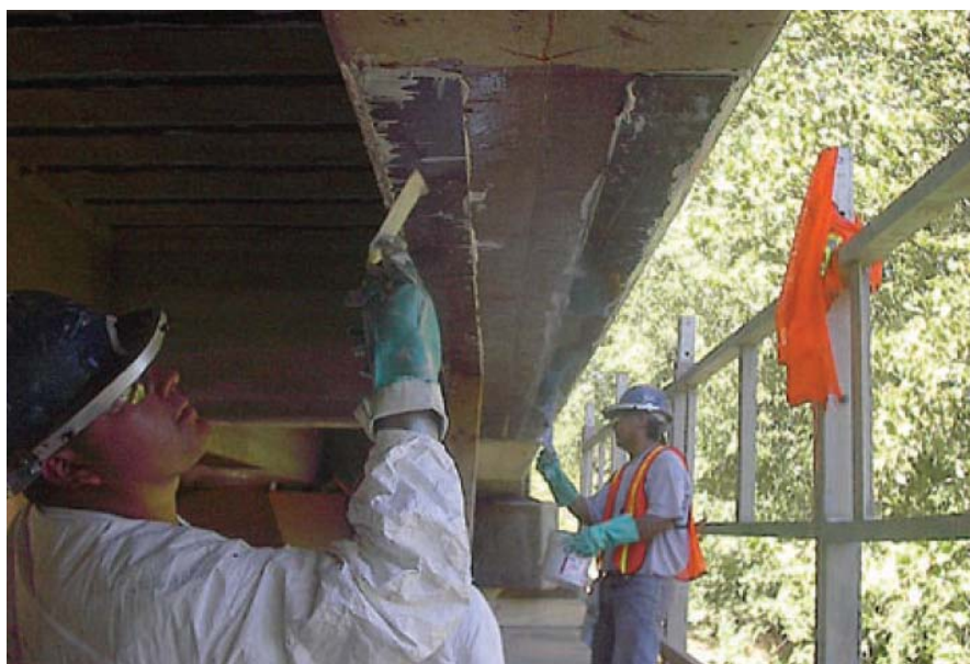
תרשים ו-2: הוספת יריעות CFRP לרכיב בטון קיים
