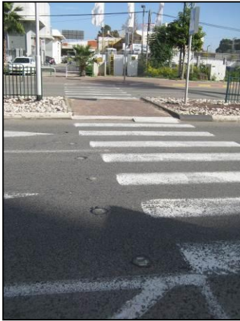
איור 17 : עיני חתול אקטיביות ורמפת הנגשה במעבר חציה בקרבת הדיור המוגן
