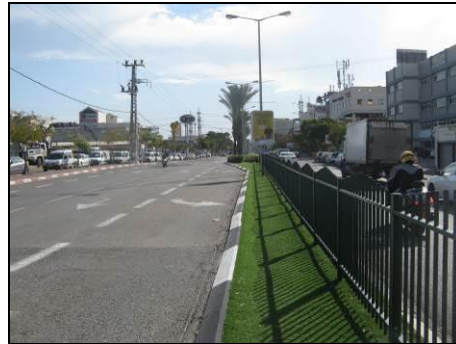
איור 18 : גדר הברזל על גבי המפרדה הבנויה למניעת חציית הולכי רגל
