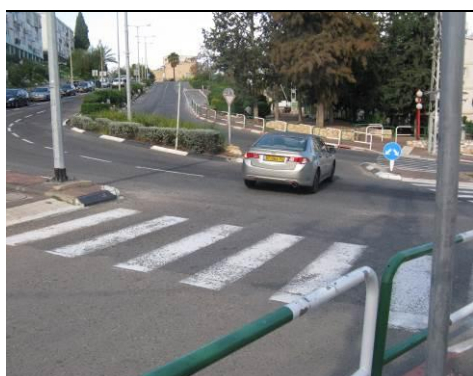
איור 7 : נקודת קונפליקט רכב-רכב בעייתית בסמיכות למעבר החציה אשר גורמת לחסימת שדה הראיה ומסכנת את הולכי הרגל
