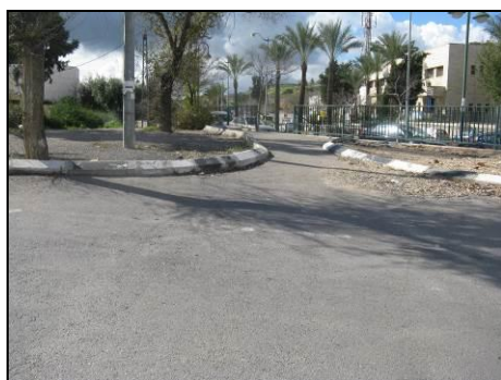
איור 4 : כניסת הולכי רגל אל רחבת חניה – לא קיימת תשתית מדרכות.
