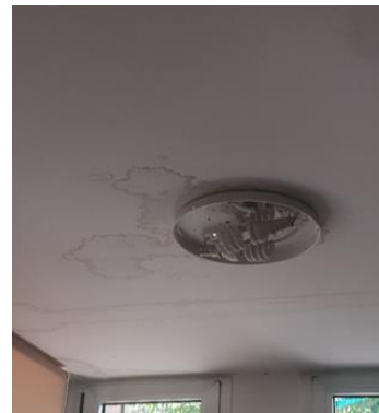
רטיבות בתקרה סמוך לנקודת חשמל, עלולה לגרום לקצר וסכנת התחשמלות.
