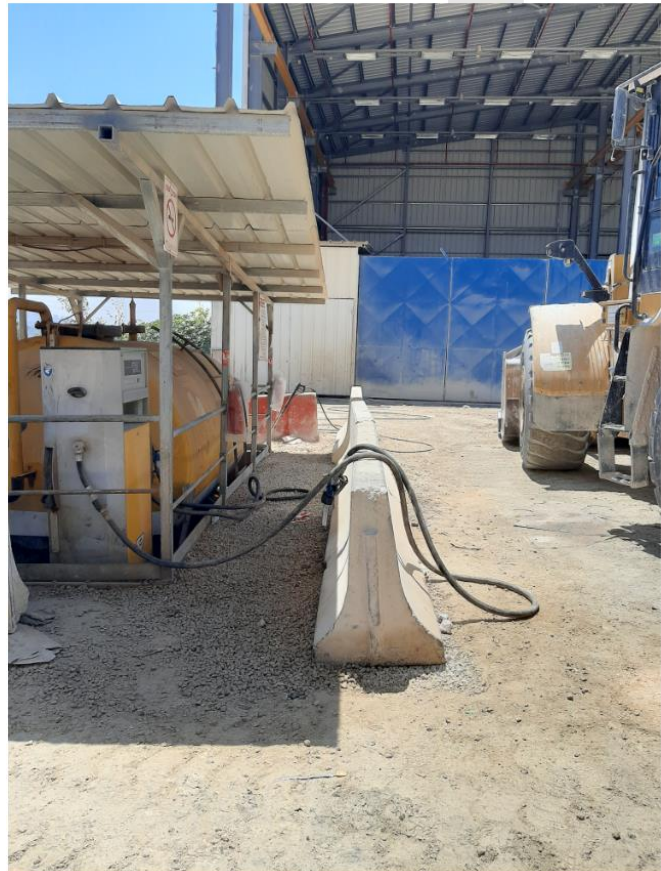
תמונה 5- עמדת תדלוק מבוצעת שלא על גבי משטח תפעול אטום למניעת חלחול, אלא על גבי אספלט.
