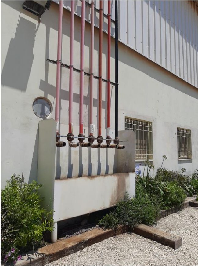
תמונה 6- עמדת מילוי מיכלי שמו הידראולי ושמונים תפעוליים, למיכלים בקומה העליונה של המוסך.
