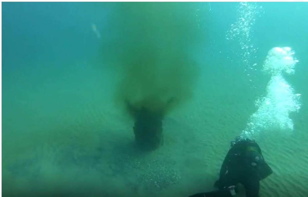
תמונה 2 - גובה זקף ההזרמה לים כמטר מעל הקרקעית, אין הצטברות חולות ביחס למצב בשנה שעברה
