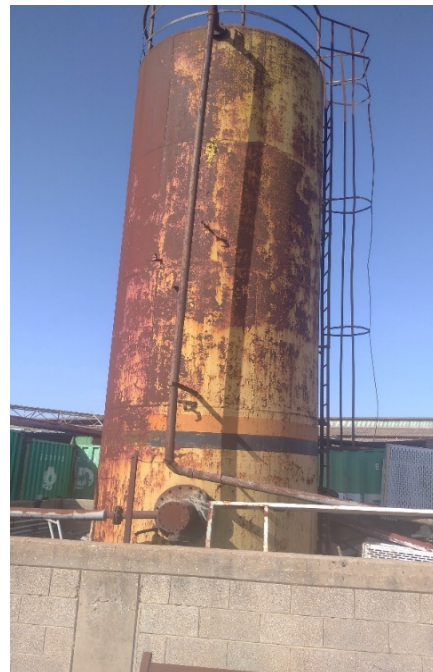
תמונה 1- מיכל המזוט במזרח המתחם - בסיור לא נצפה שפך או חורים/סדקים במאצרה
