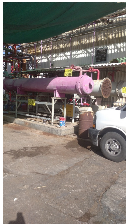
תמונה 7- אחסנת אמוניה נוזלית במערכת סגורה ומבוקרת.
