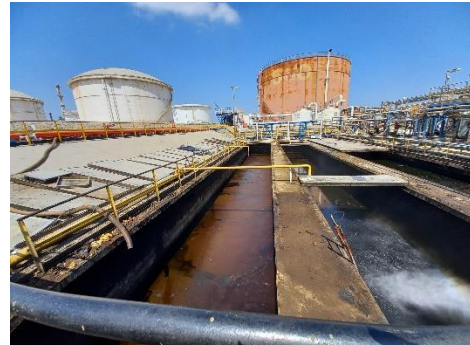
מפרידי ה-API במהלך עבודות הניקוי (28/6/22)
