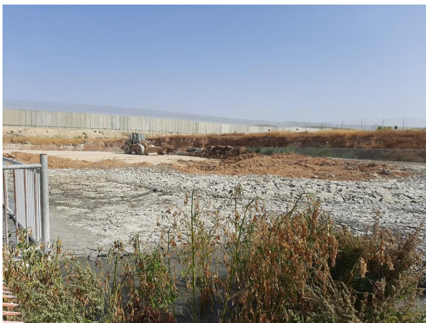
תמונה מספר 1- עבודות פינוי בוצה במשקע המלבני הצפוני (צולם ע"י אסנת מלכה)
