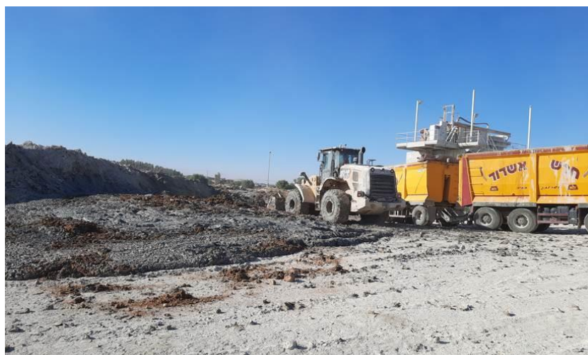
תמונה 3- שופל מעמיס חומר מינרלי/סדימנטים על משאית לצורך פינוי לאתר הטמנה מורשה
