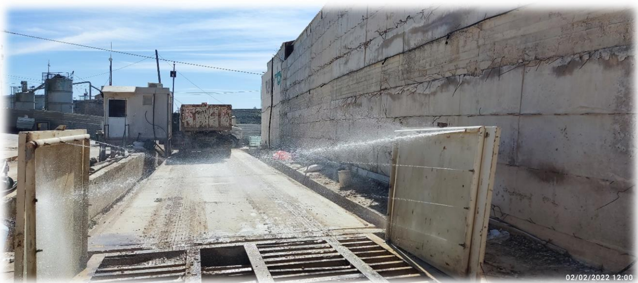
תמונה 5 – מתקן שטיפת הגלגלים פועל לאחר מעבר המשאית בתוכו. עוצמת המים התגברה אחרי שהמשאית עברה במתקן
