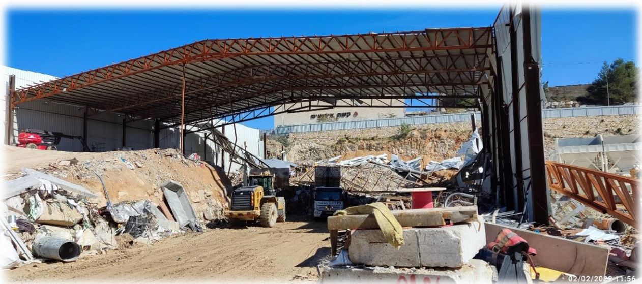
תמונה 3 – אזור קליטת ומיון הפסולת, לאחר קריסת חלק מהגג והקירות שתחמו אותו. משאית פורקת פסולת בתוך המתחם
