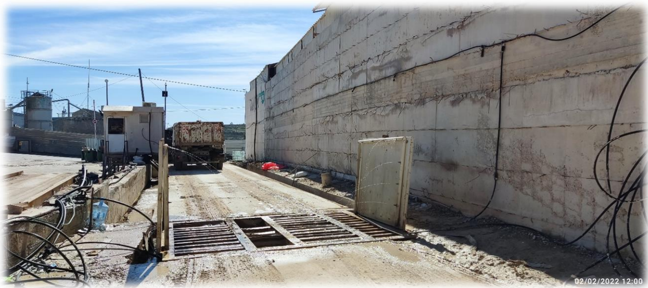
תמונה 4 – מתקן שטיפת הגלגלים פועל לאחר מעבר המשאית בתוכו. הזרם היוצא חלש
