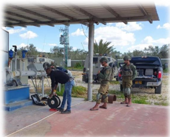
מעקב אחר החלפת ציוד בקידוחים - מערכת סינון חדשה בקידוח עוג'ה החדש - בקעת הירדן - שטח A
