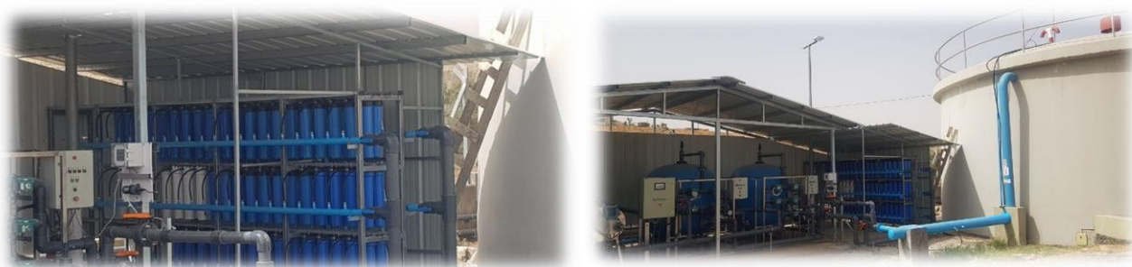
מעקב אחר החלפת ציוד בקידוחים - מערכת סינון חדשה בקידוח עוג'ה החדש - בקעת הירדן - שטח A
